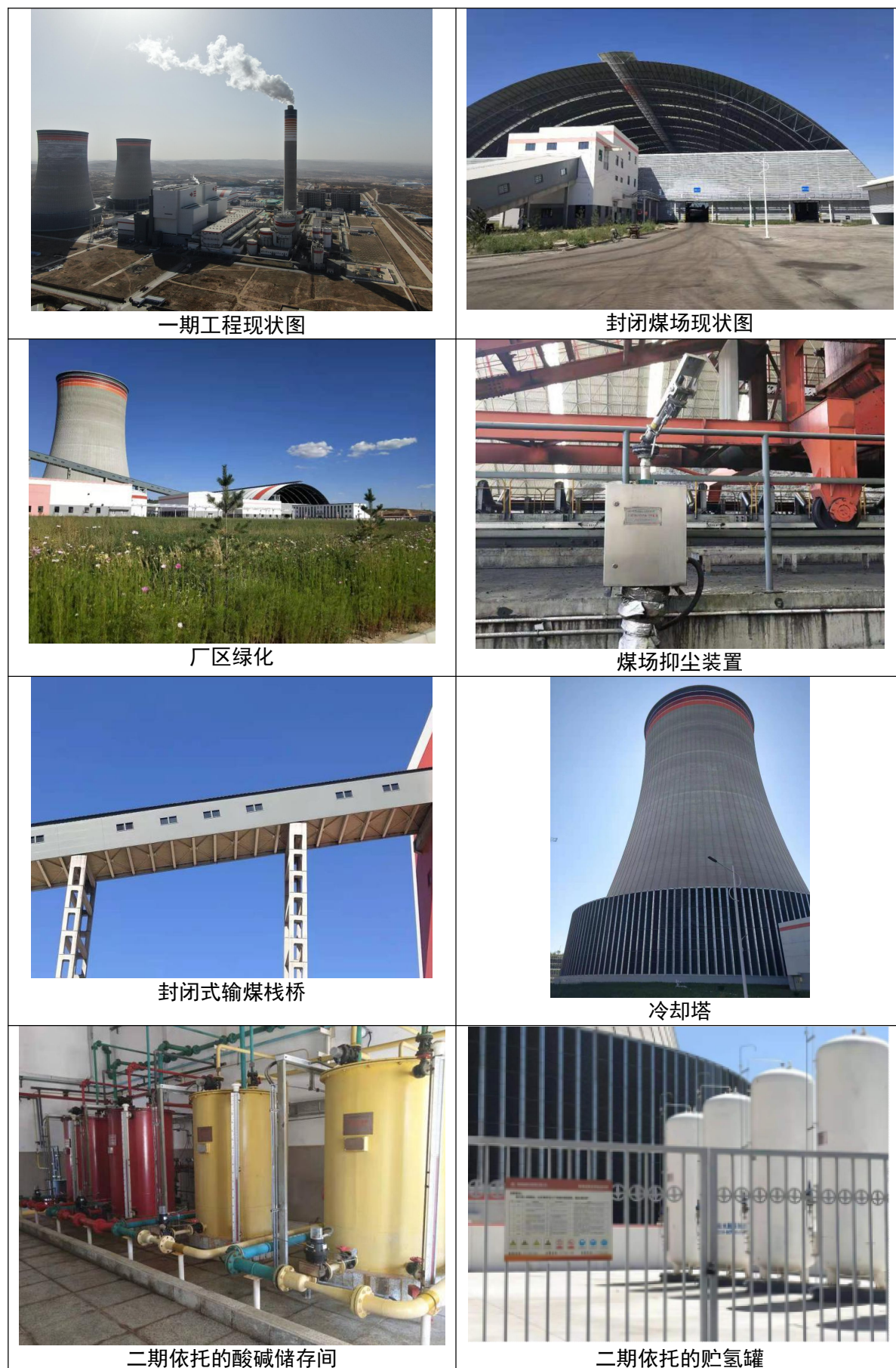
图3.1-2 厂区现状照片
