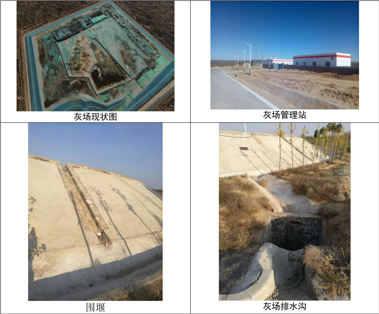
图 3.1-3 灰场现状照片
