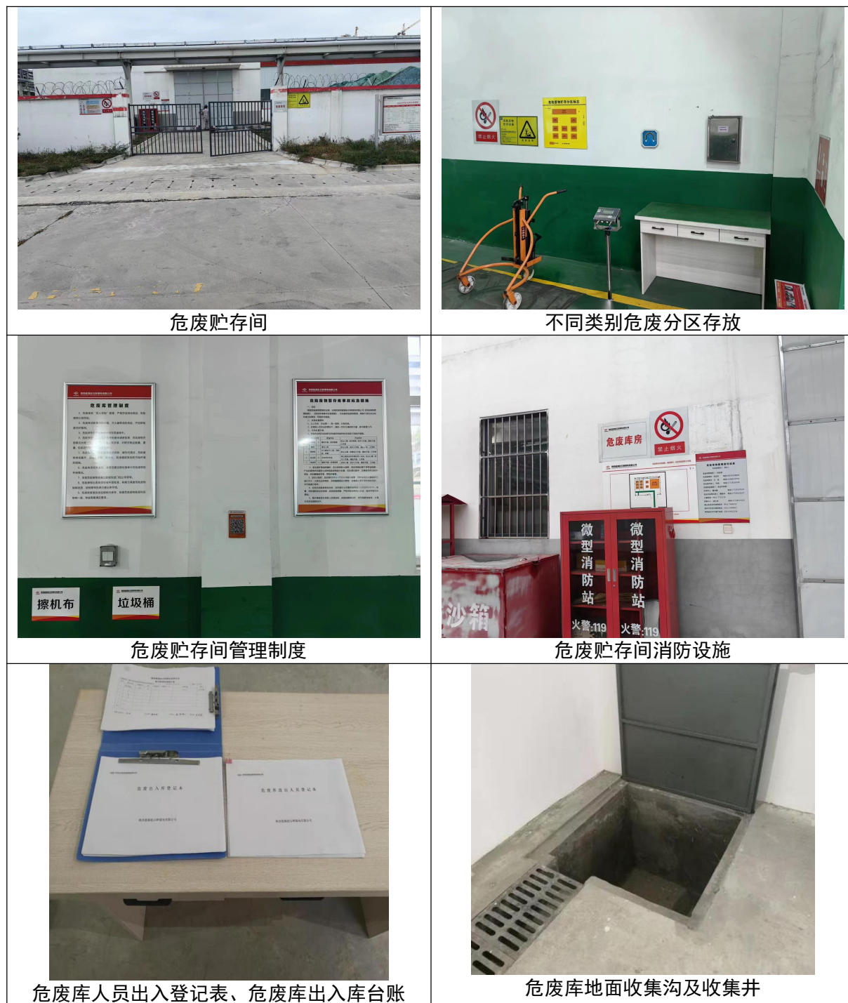
图 3.1-12 危废贮存间现状图
