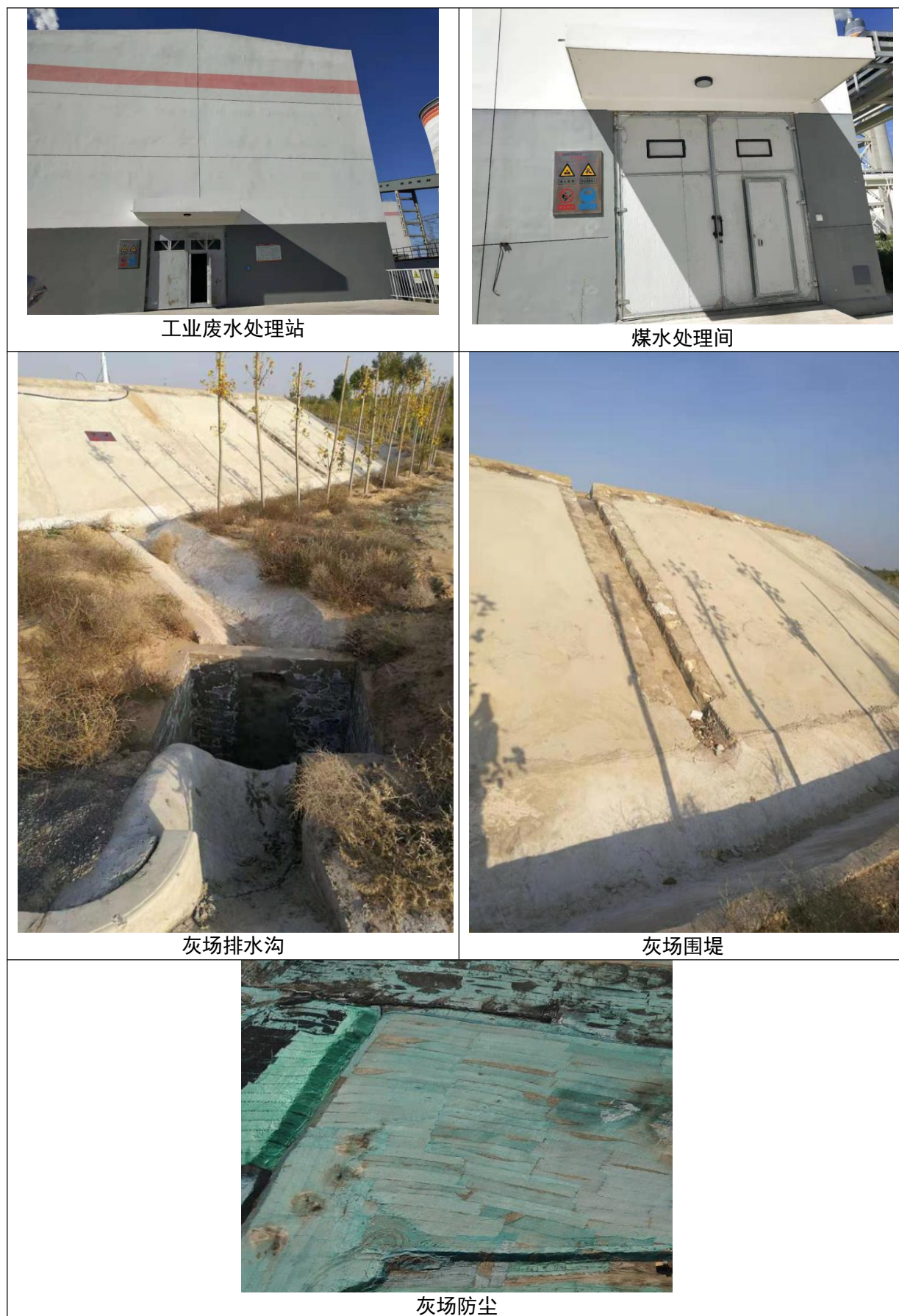
图 3.1-6 一期工程主要环保设施现状照片
