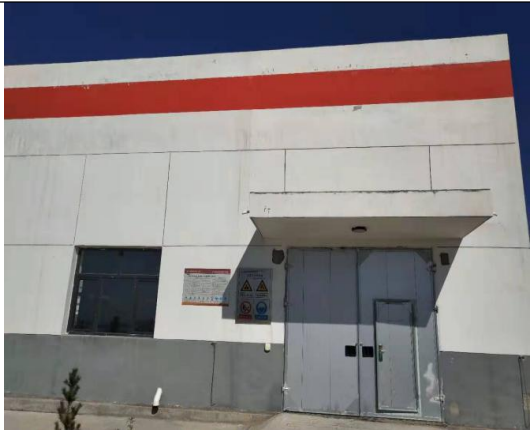
生活污水处理站
