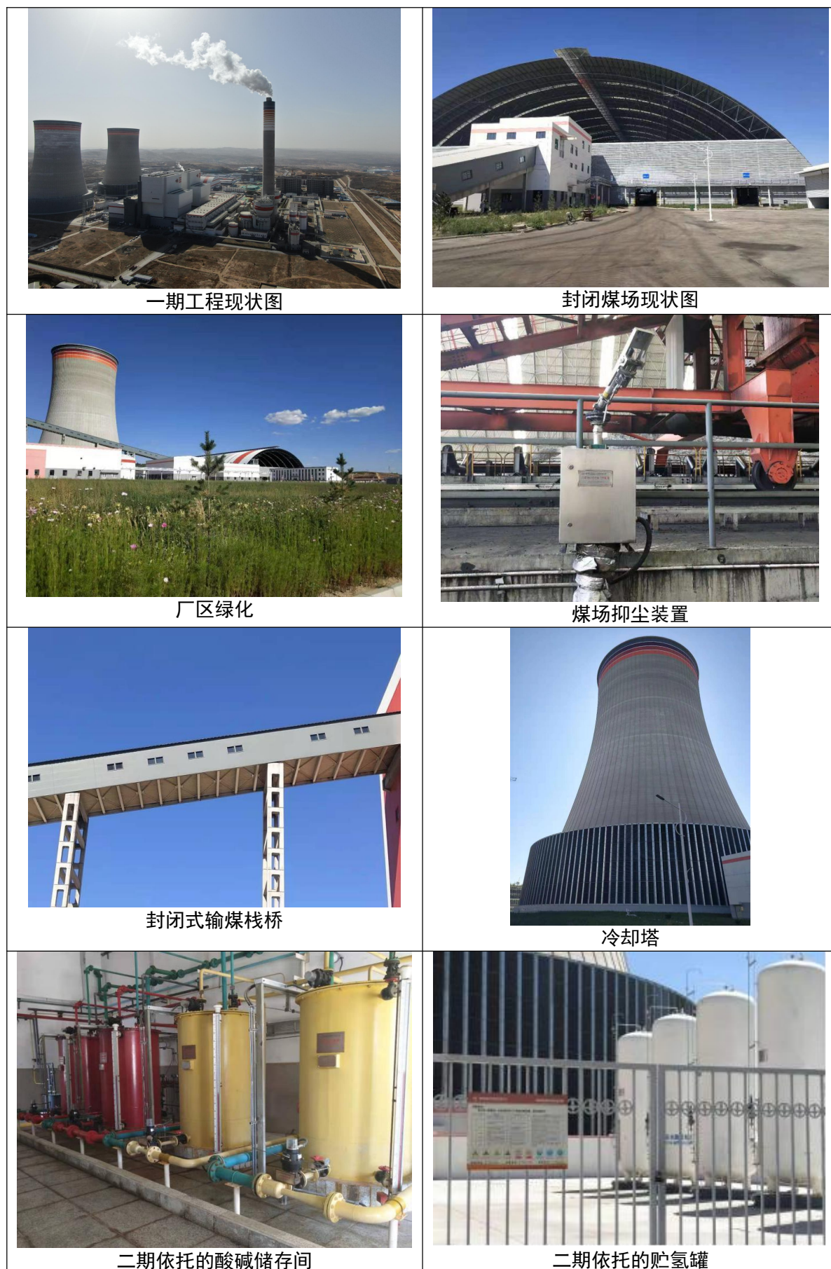
图3.1-2 厂区现状照片
